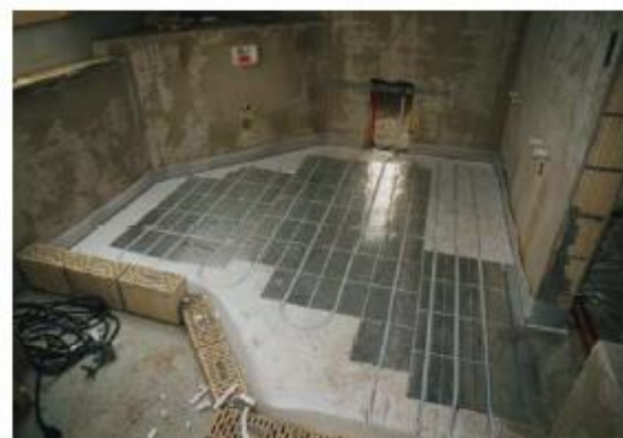
Wärmeverteilung Fussbodenheizung
