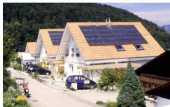
Solaranlage für Heizung + Warmwasser
