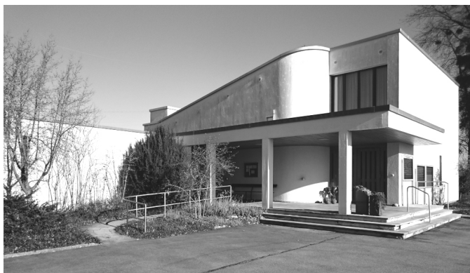
Die Aufbahrungs- und Abdankungsräume werden saniert.
