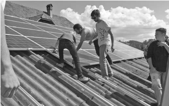
Beim Bau einer Solaranlage tatkräftig mitzuhelfen, war für viele ein Highlight.
